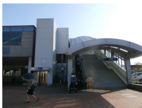
エレベーター、エスカレーター設置で喜ばれているJR下曽根駅
