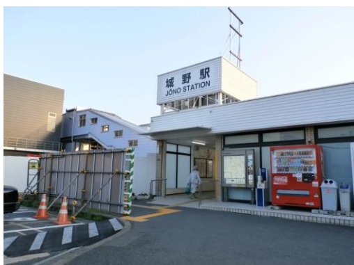
エレベーターが設置され、道路整備と合わせ、改善が進むJR城野駅
